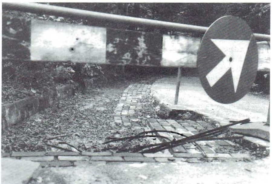
Het asfalt is weggeschrapt, het fundament ligt er.
