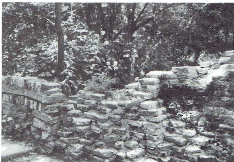
De eerste plantengroei op de nieuwe muur, voorjaar 1997. Foto: Pieter van Balkum
