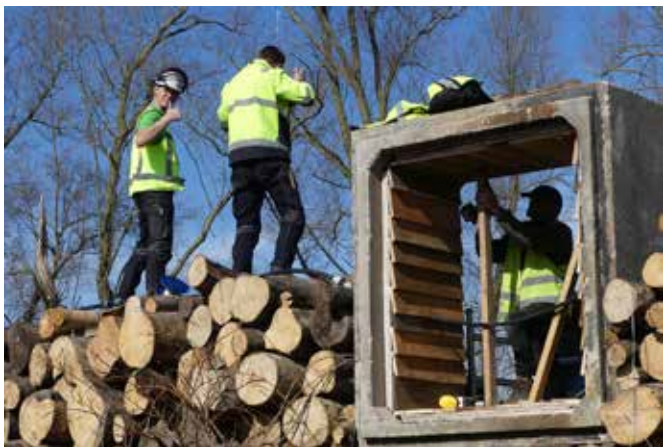
Aanleg van de Floriade in Almere
